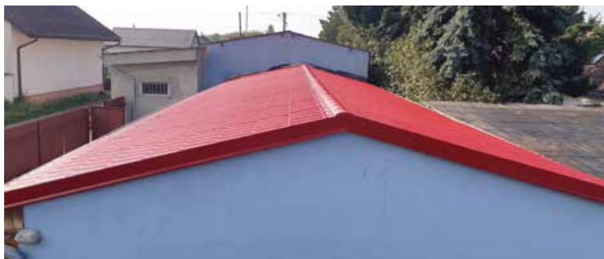
Nová strecha na hasičskej zbrojnici.
